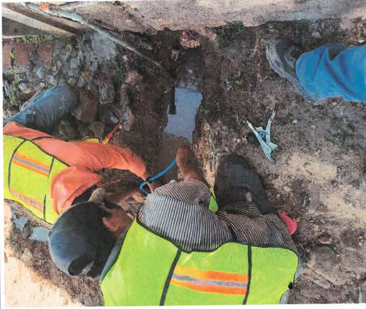
REPOSICION DE TOMAS DE AGUA POTABLE
